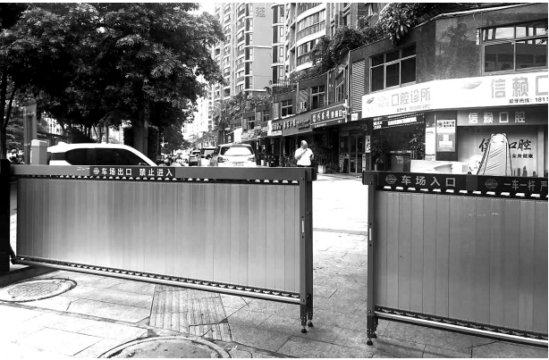
整改前，小区外的盲道被停车场占用，给行人带来不便。
