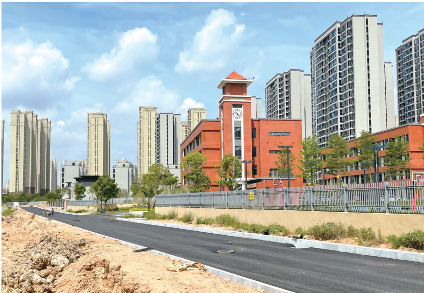
工人正在紧张施工中。
