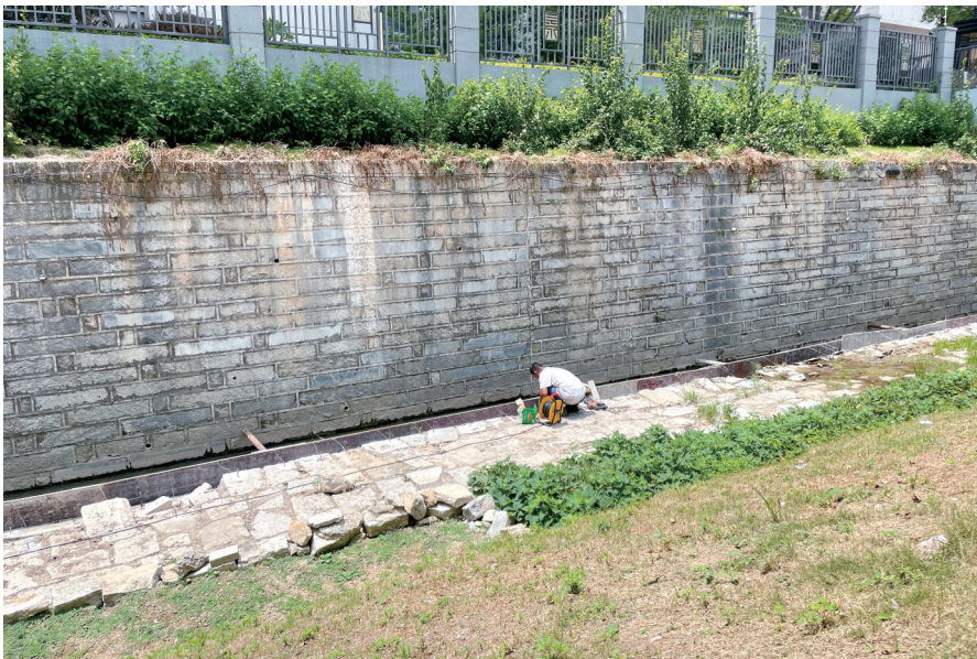
工人在普照溪沿岸做加固工作。
