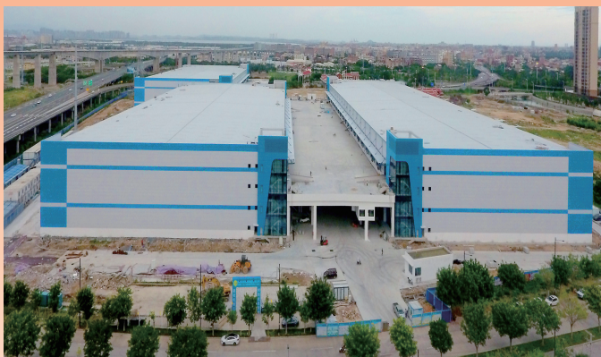
京通易购(东南)智慧物流共同运营中心,总投资50000万元。该项目三个仓库外立面装饰已基本完工,计划年底投产使用。
