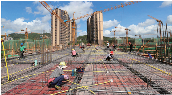
罗山中心小学扩建工程,总建筑面积3.7万平方米,总投资12169万元,第三、四季度要完成教学楼、科技楼、艺术楼、办公图书馆等主体建设。
