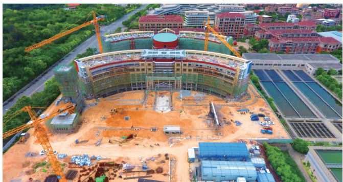
晋江市第二实验小学梅岭校区,总建筑面积3.1万平方米,总投资30774万元,第三季度竣工投用。
