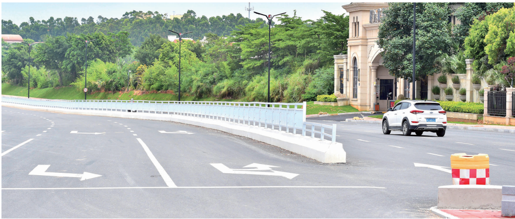
灵石路拓改提升,完善交通路网。
