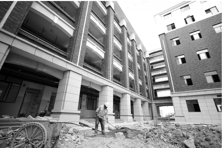
养正中心小学新校区项目一期工程加紧建设。
