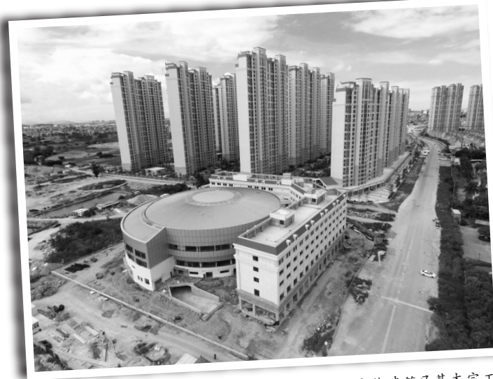
欧洲大马戏团项目主体建筑已基本完工。
