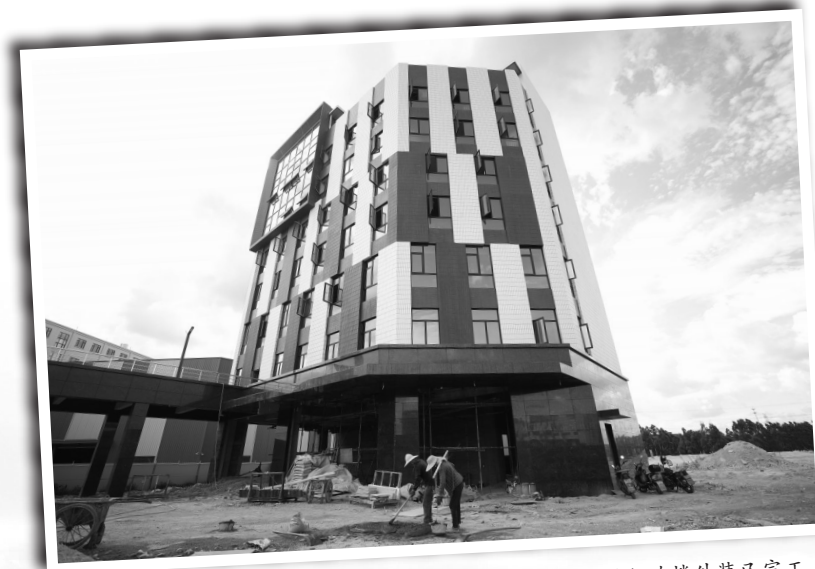
安能新材料股份有限公司行政楼外装已完工。
