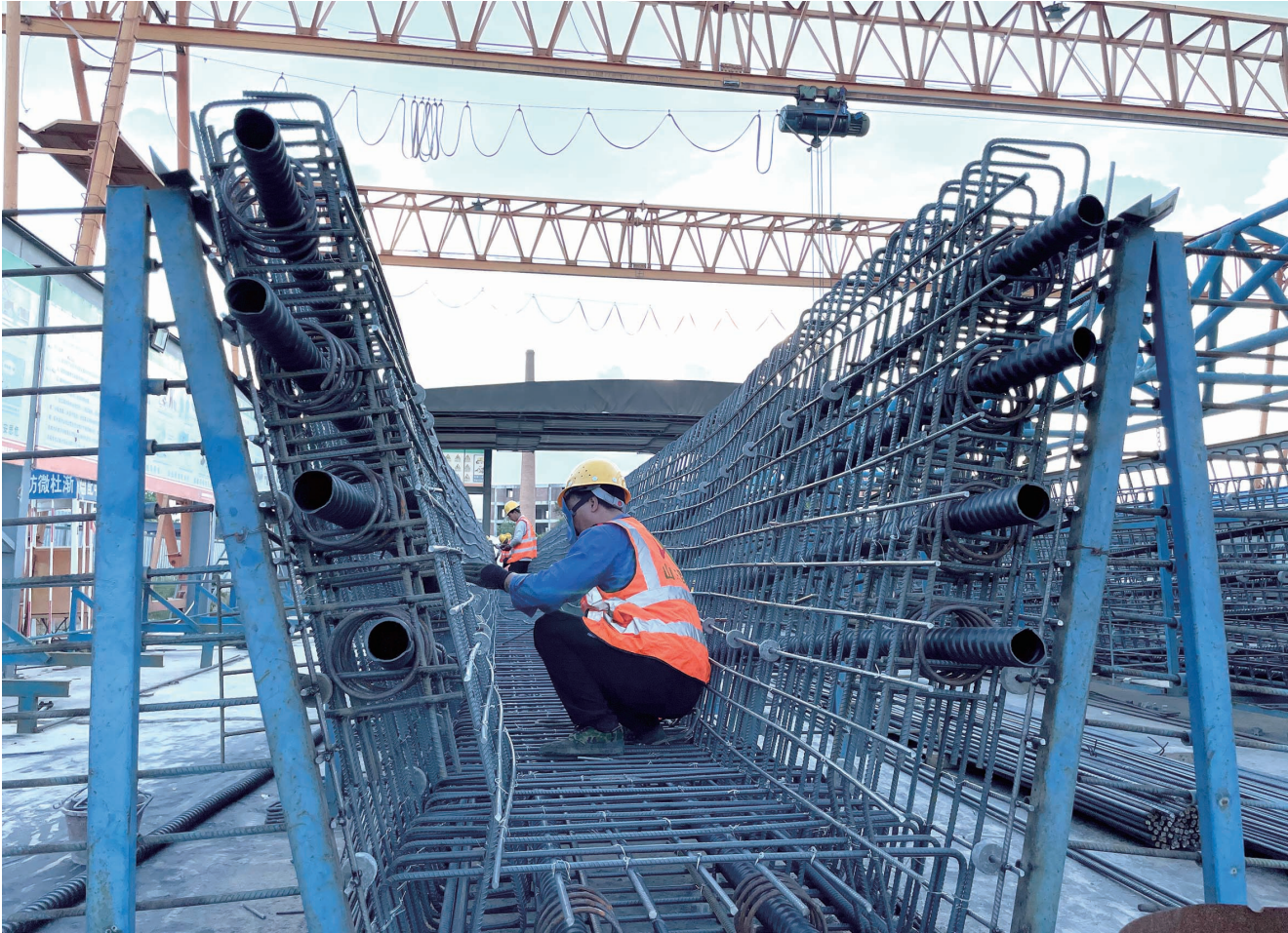
工人正在捆扎钢筋。 本报记者 阙杨娜 摄
