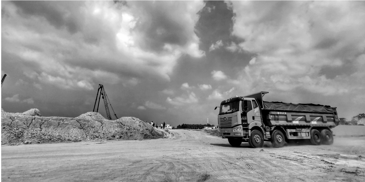
顺丰创新产业园项目现场施工场面热火朝天。本报记者 赖自煌 摄
