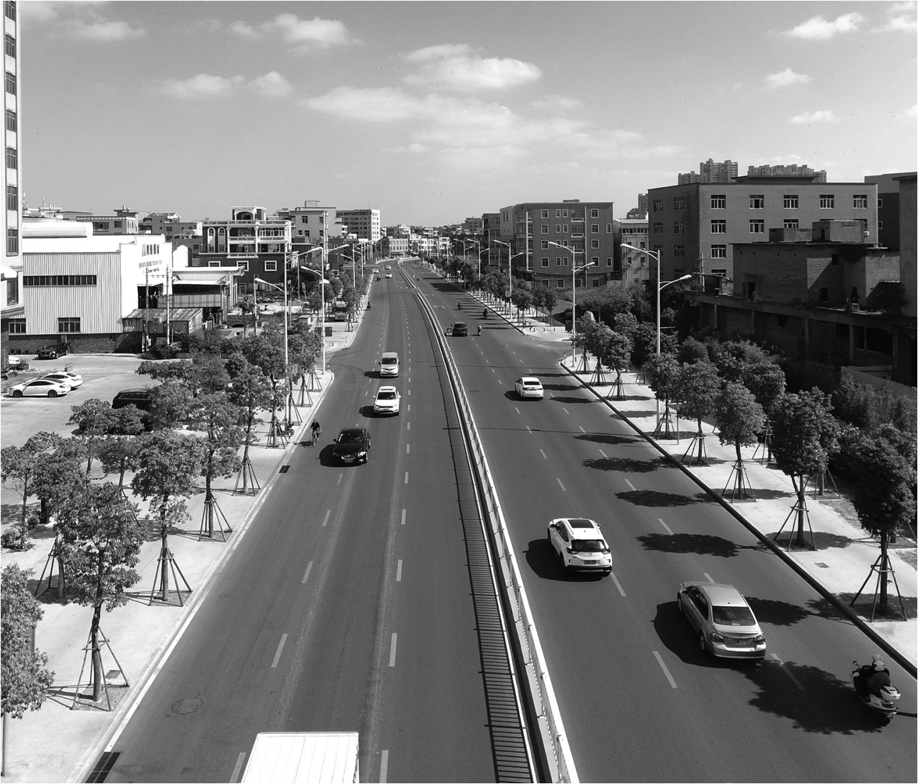
安海镇持续推进城乡重要通道沿线的环境整治,城镇面貌显著提升。
