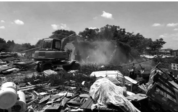
安海镇全力推进临时搭盖大整治。
