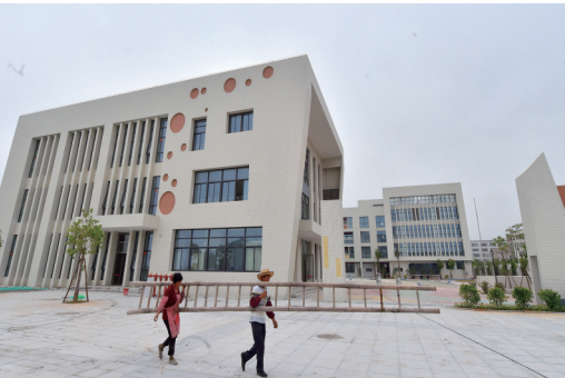
幼儿园的内外装修已完成。 本报记者 陈巧玲 摄
