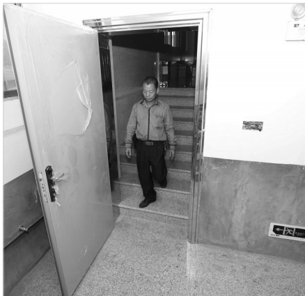
可慕制革集控区内企业完成消防安 门安装。 本报记者 秦越 摄
