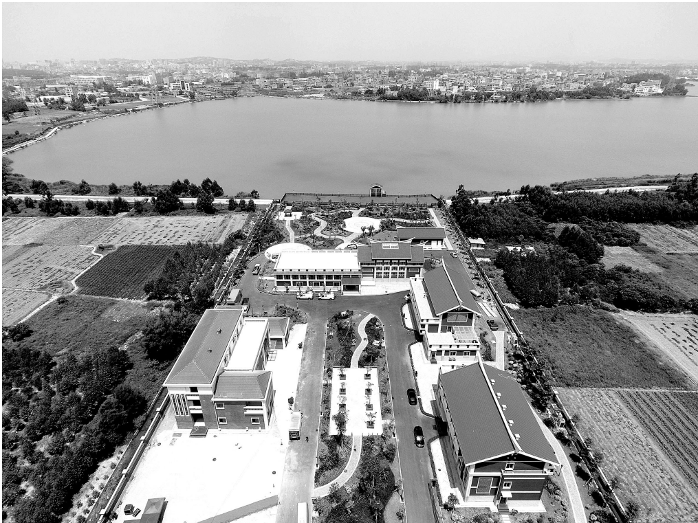
金門供水工程水源地——晉江龍湖泵站(資料圖片)
