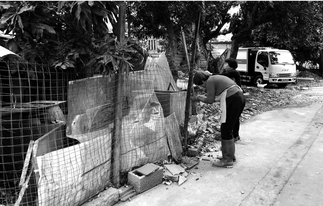
社区居民自行拆除鸡鸭棚舍。
