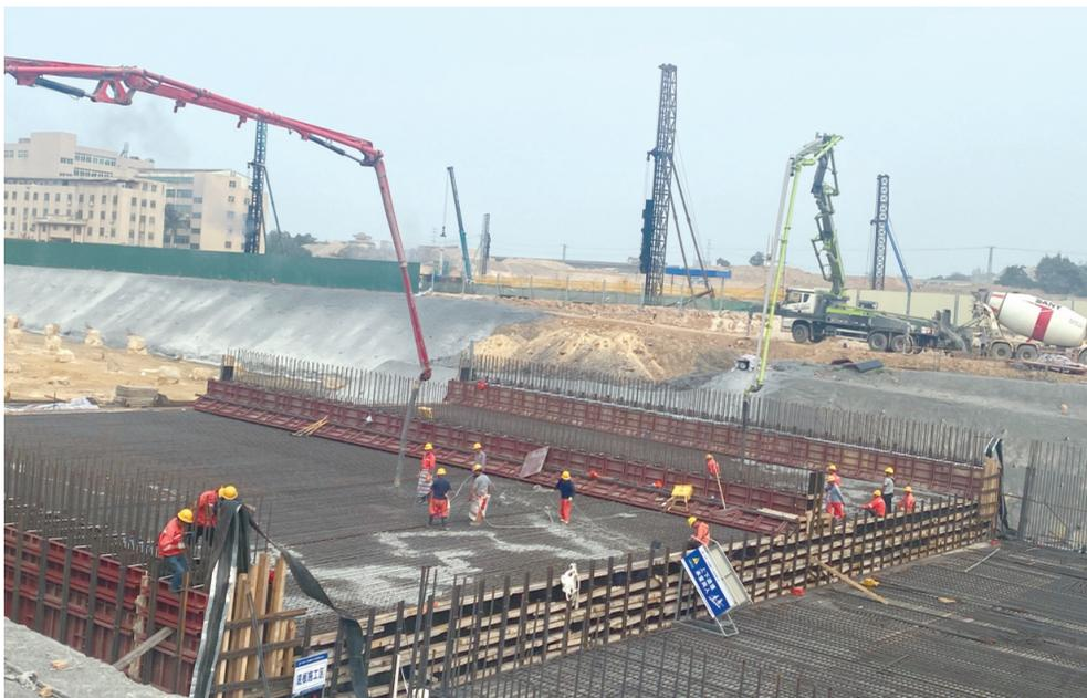
昨日,记者从晋江路桥公司获悉,晋江市东部快速通道一期工程A2标项目主线隧道首段底板顺利浇筑完成,这也意味着隧道主体结构进入全面施工阶段。
