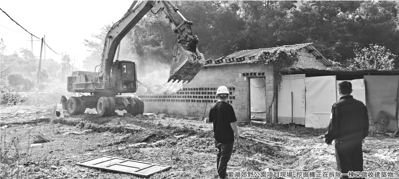
紫湖郊野公園項目現場，挖掘機正在拆除一棟已徵收建築物。
