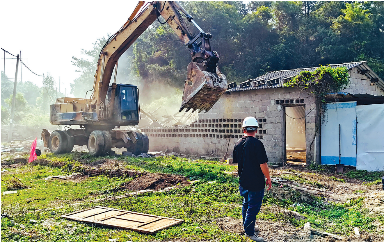
紫湖郊野公园项目现场,挖掘机正在拆除一栋已征收建筑物。
