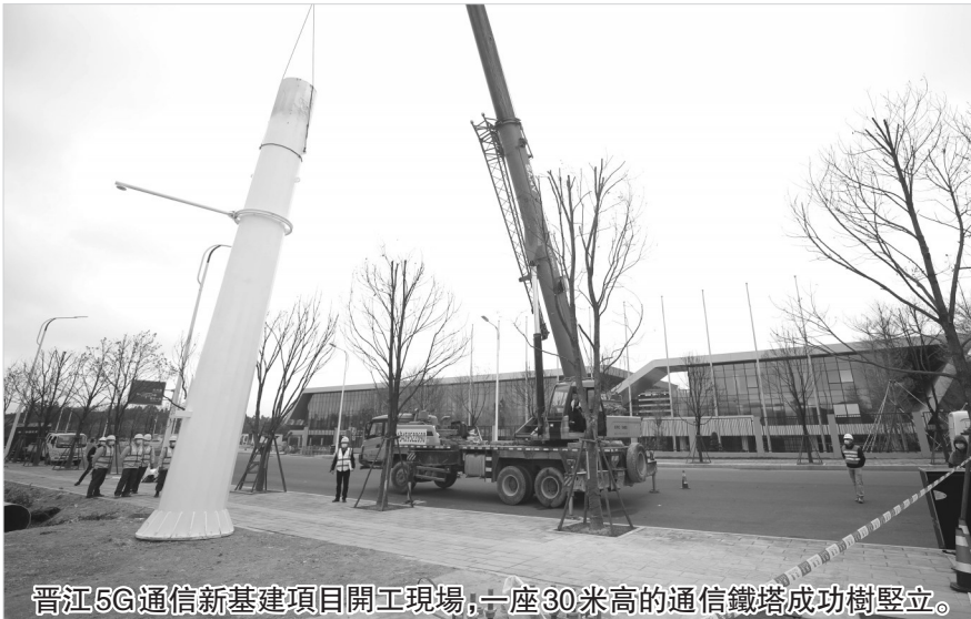
晉江5G通信新基建項目開工現場,一座30米高的通信鐵塔成功樹立。
