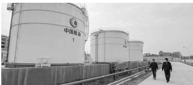
泉州晉江國際機場油庫及航空加油站遷建項目竣工。
