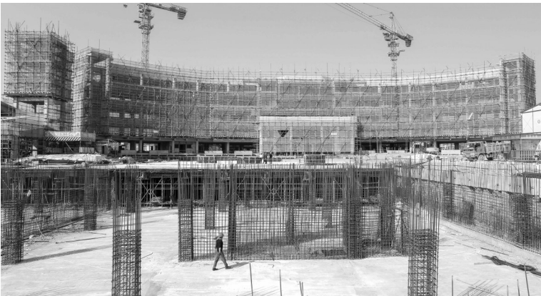
晉江二小梅嶺校區施工現場。
